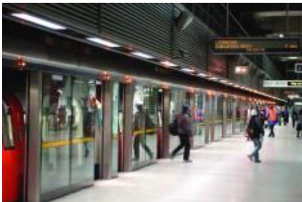
Рисунок 3.20 – Дверная система перрона
